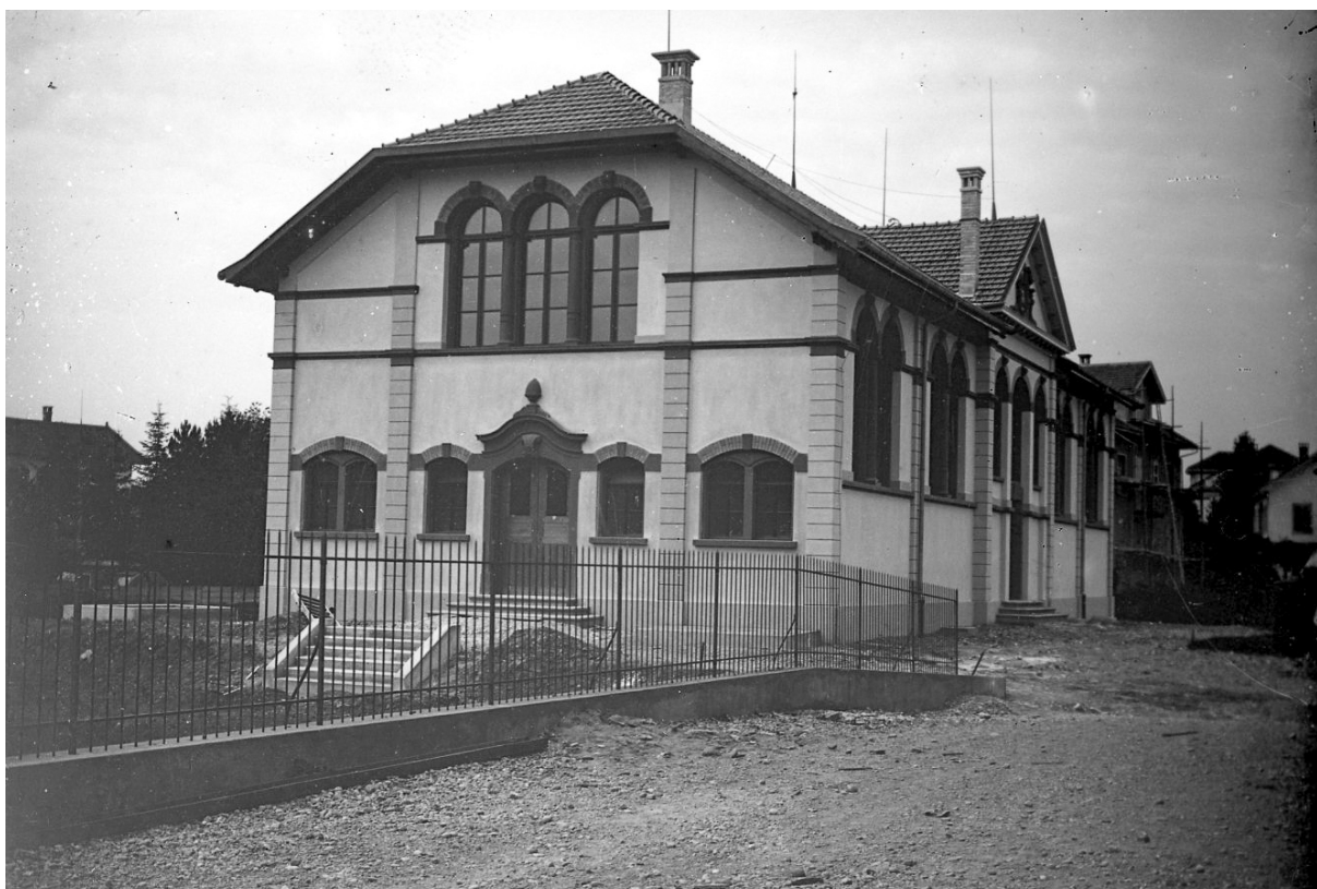
Ansicht von Osten, 1901 während der Fertigstellung (Bürgerarchiv)
