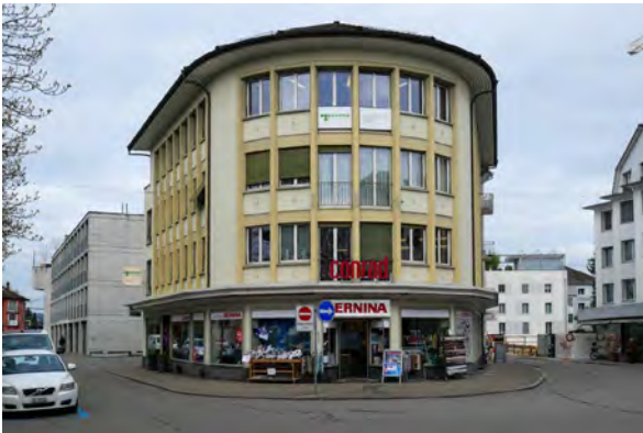
Pestalozzistrasse 12 Wohn- und Geschäftshaus «City-Haus», 1953 von August Bächle Geschütztes Kulturobjekt Hinweisinventar: «Beispiel eines neueren Geschäftshauses, das seine Aufgabe als Strassenteiler mit repräsentativen Rasterfassaden gut erfüllt.» Einstufung: wertvoll Strassenfluchtbildend, abgerundete Ecke an der Strassenverzweigung
