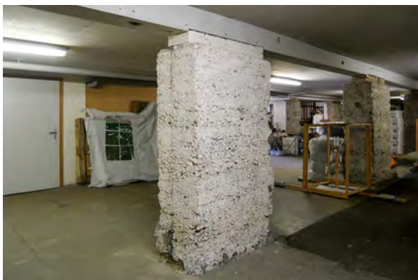
Pfeiler aus Stampfbeton und Deckenträger aus Eisen (Fotos: Michael Hanak, 2022)
