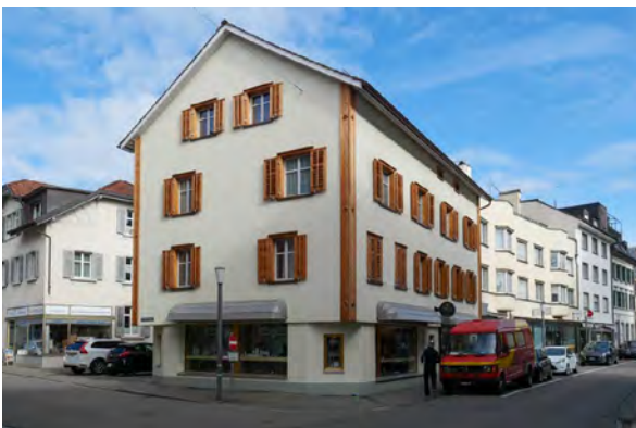
Rathausstrasse 34 Wohnhaus mit Laden, zw. 1900 und 1915 Geschütztes Kulturobjekt Hinweisinventar: «In Eckstellung an der Strassenverweigung Rathaus-/Schmidstrasse gelegenes einfaches verputztes Wohn- und Geschäftshaus.» Einstufung: wertvoll Strassenfluchtbildend
