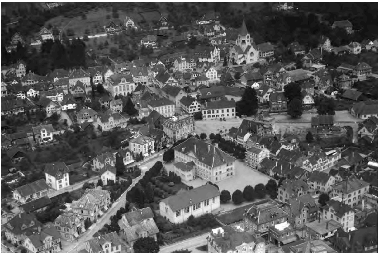
Luftaufnahme von Südwesten, 1932 (ETH Bildarchiv)
