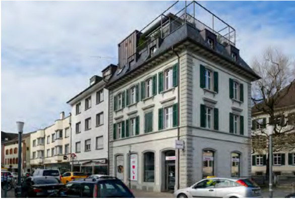
Rathausstrasse 26 Wohn- und Geschäftshaus, ehem. Wohnhaus, 1893 Geschütztes Kulturobjekt Hinweisinventar: «Qualitätvoll gegliederter, dreigeschossiger Baukörper im klassizistischen Stil. Erdgeschoss mit hohen Schaufenstern. Wertvolle Ausstattung der Räume zu vermuten. Wichtig als Zeilenelement. Zusammen mit Marktstrasse 2 markante Kopfsituation bezüglich des südlichen Teils der Rathausstrasse. Formale und stilistische Verwandtschaft mit Pestalozzischulhaus.» Einstufung: wertvoll Strassenfluchtbildend, rustiziertes Sockelgeschoss, Ecklisenen
