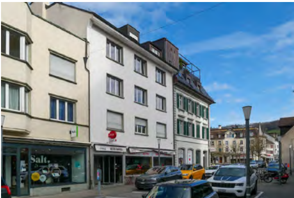
Rathausstrasse 28 Wohn- und Geschäftshaus, ca. 1930er Jahre Geschütztes Kulturobjekt Hinweisinventar: «Einfacher viergeschossiger Verputzbau. Im Erdgeschoss moderner Ladeneinbau.» Einstufung: bemerkenswert Strassenfluchtbildend
