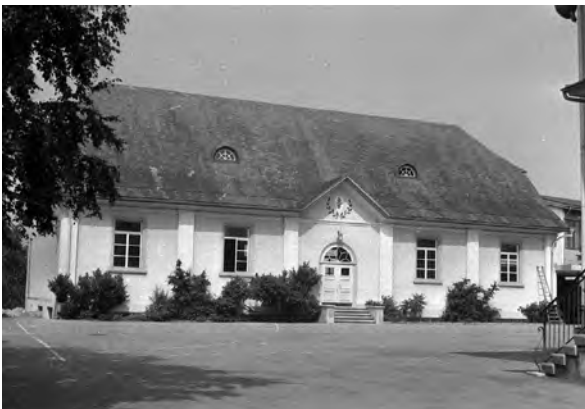
Turnhalle, Amriswilerstrasse 8a, Egnach 1926 Freistehende Turnhalle mit Stutzwalmdach, Fassadengliederung durch schlichte Lisenen. In der Längsfassade Mitteleingang mit bekrönendem Giebel. Ähnlichkeiten: Walmdach, regelmässige Befensterung, Lisenen, Dreiecksgiebel über dem Eingangsportal
