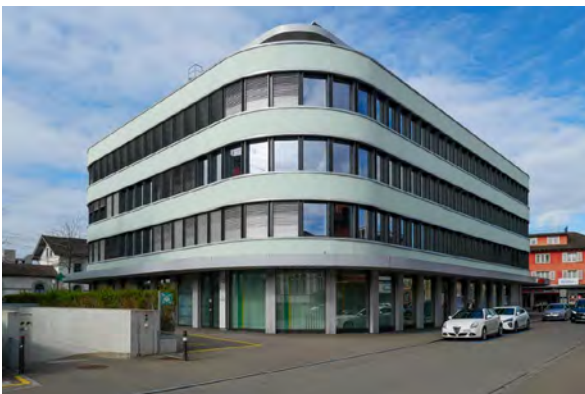
Bahnhofstrasse 12 Geschäftshaus, zw. 2010 und 2020 Viergeschossiger Flachdachbau mit zurückversetztem Attika und gerundeten Ecken Strassenfluchtbildend, horizontale Brüstungsbänder
