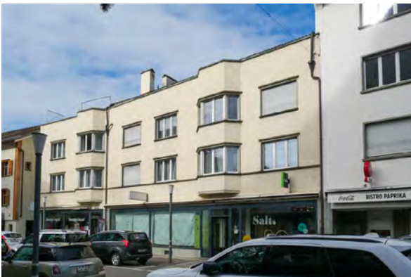
Rathausstrasse 30/32 Geschützte Kulturobjekte Zwei Wohnhaus- und Geschäftshäuser, 1937 Hinweisinventar: «Gestrecktes dreigeschossiges Wohn- und Geschäftshaus, verputzt, mit Fassadenerkern. Gesamte Breite des Erdgeschosses moderne Ladenlokale mit Schaufenstern.» Einstufung: wertvoll Strassenfluchtbildend, Erker
