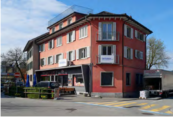
Bahnhofstrasse 1a Wohn- und Geschäftshaus mit «Bistro & Take-away Gleis 1», zw. 1930 und 1945 Dreigeschossiges Eckgebäude mit gewalmtem Dach und Schlepplgaube, mit erneuertem Ladengeschoss und rückseitigem Anbau, heute mit rotem Fassadenanstrich Strassenfluchtbildend, abgeschrägte Gebäudeecke, Holzsparrenvordach
