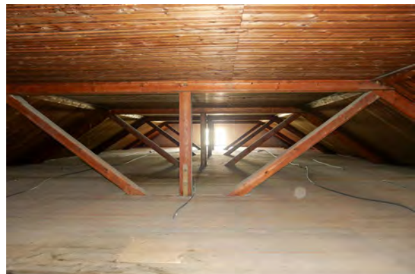
Verkleidete Deckenträger und darüber liegender Estrich mit Täferdecke (Fotos: Michael Hanak, 2022)
