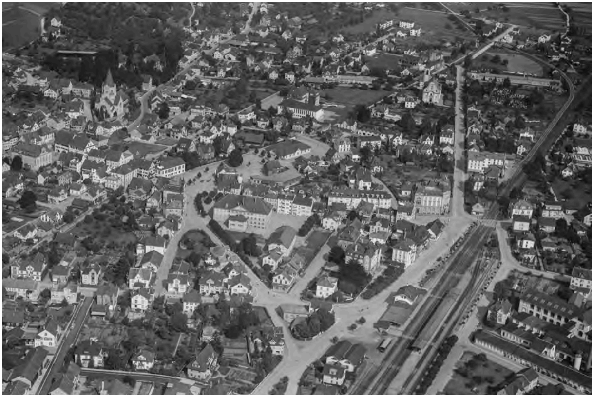
Luftaufnahme von Süden, 1948 (ETH Bildarchiv)
