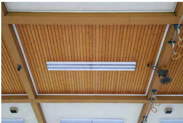
Verkleidete Deckenträger und darüber liegender Estrich mit Täferdecke (Fotos: Michael Hanak, 2022)
