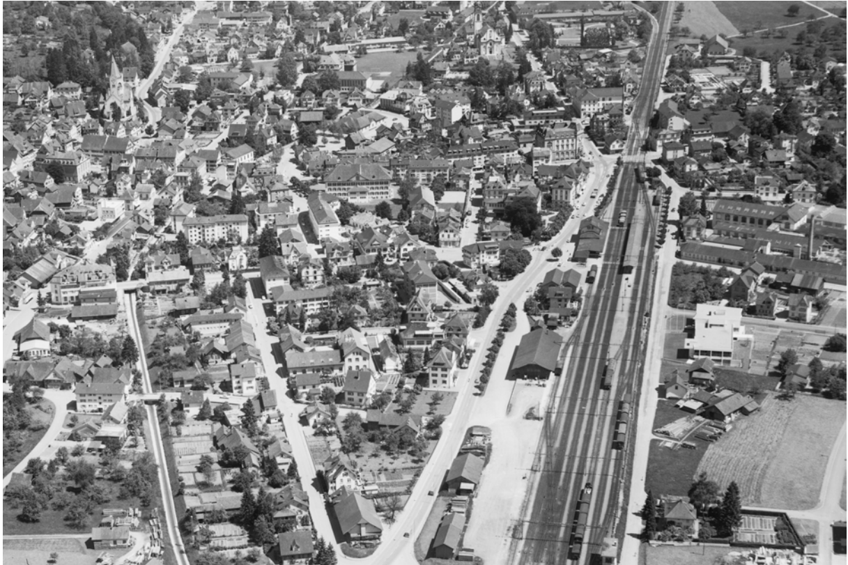
Luftaufnahme von Westen, 1962 (ETH Bildarchiv)
