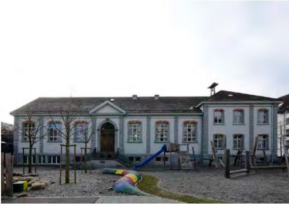
Turnhalle, Schulstrasse 1, Romanshorn 1902 von August Keller Zweiteiliger Bau aus zweigeschossigem und eingeschossigem Verputzbau mit klassisierenden Formen über rustiziertem Sockel. Regelmässige Fassadengliederung durch geschossübergreifende Pilaster und Befensterung. Fenster mit geohrtem Gewände, farblich abgesetztem Sichtbacksteinsturz sowie Scheitelstein. Feines Gurtgesims scheidet Obergeschoss vom Kniestock. Kranzgesims mit Klötzchenfries. Abgewalmtes Dach mit Dachreiter und Glocke. Nordfassade mit rustiziertem Rundbogenportal, Scheitelstein und Frontispiz über zweiarmiger Treppe. Ähnlichkeiten: Walmdach, regelmässige Befensterung, gequaderte Lisenen
