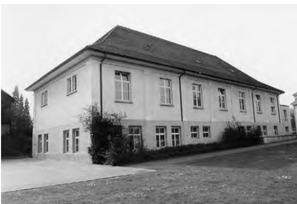
Schreiberschulhaus-Turnhalle, Schulstrasse 20.2, Kreuzlingen 1914/15 Freistehende Turnhalle mit Walmdach. Zum Schreiberschulhaus im Westen gehöriger Turnhallenbau mit Walmdach. Fassadengliederung mit schwachen Pilastern zwischen den grossen Fenstern des Obergeschosses. Flachgedeckter niedriger Anbau im Westen aus späterer Zeit. Ähnlichkeiten: Walmdach, regelmässige Befensterung, Lisenen
