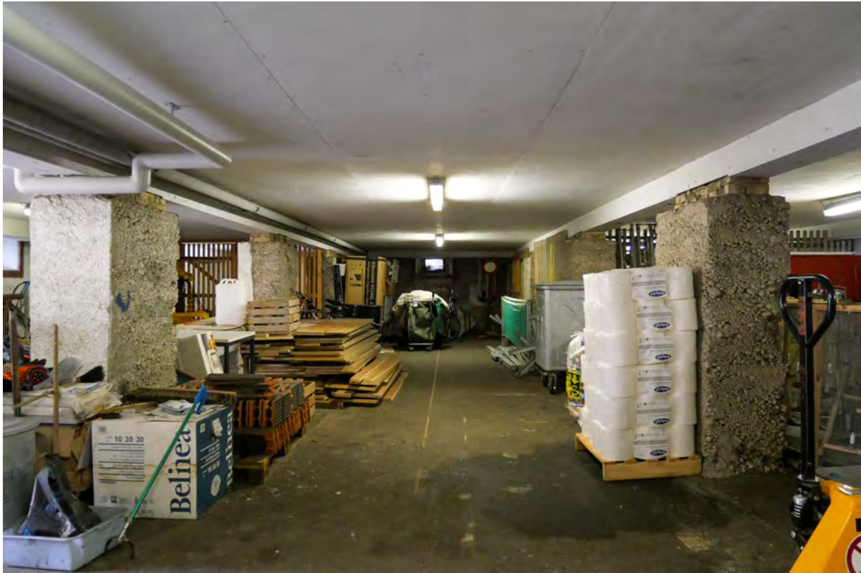
Bereich des Untergeschosses unter der Turnhalle (Foto: Michael Hanak, 2022)
