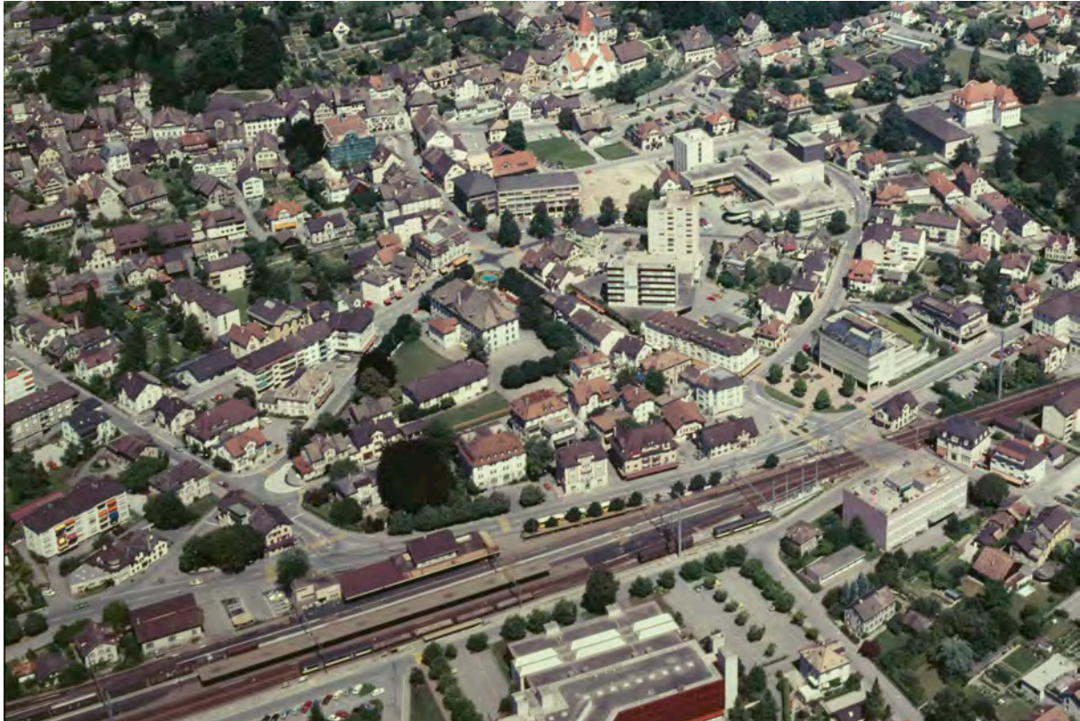
Luftaufnahme von Süden, 1985 (ETH Bildarchiv)
