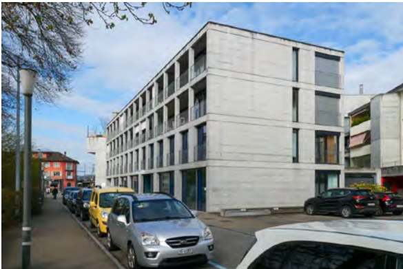
Pestalozzistrasse 14 Wohn- und Bürogebäude mit Polizeiposten Geschütztes Kulturobjekt Viergeschossiger Flachdachbau mit gerasterten Sichtbetonfassaden Strassenfluchtbildend, Quaderform, Rasterfassade
